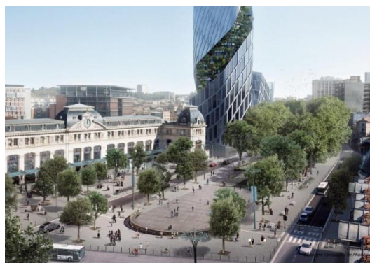
Une rupture architecturale largement décriée
