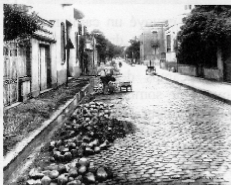
Travaux du côté du canal en début de siècle...
