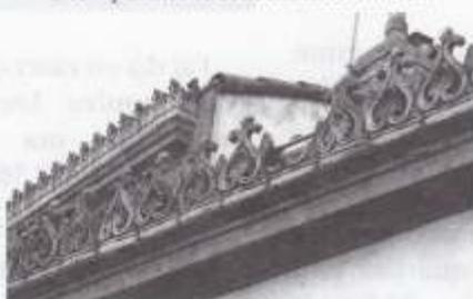
Or, les antéfixes de nos maisons nécessitent des réparations. Si le modèle est classique, on peut chercher l'équivalent. Mais on trouvera plus facilement un mouleur pour prendre une empreinte d'un élément identique à celui qu'il faut réparer (antéfixe ou autre). Un nouvel élément sera ensuite fabriqué non pas en argile, dont la cuisson provoque un retrait de près de 10%, mais en
